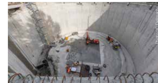
Travaux du bassin d'orage du lycée Camille Vernet à Valence.
