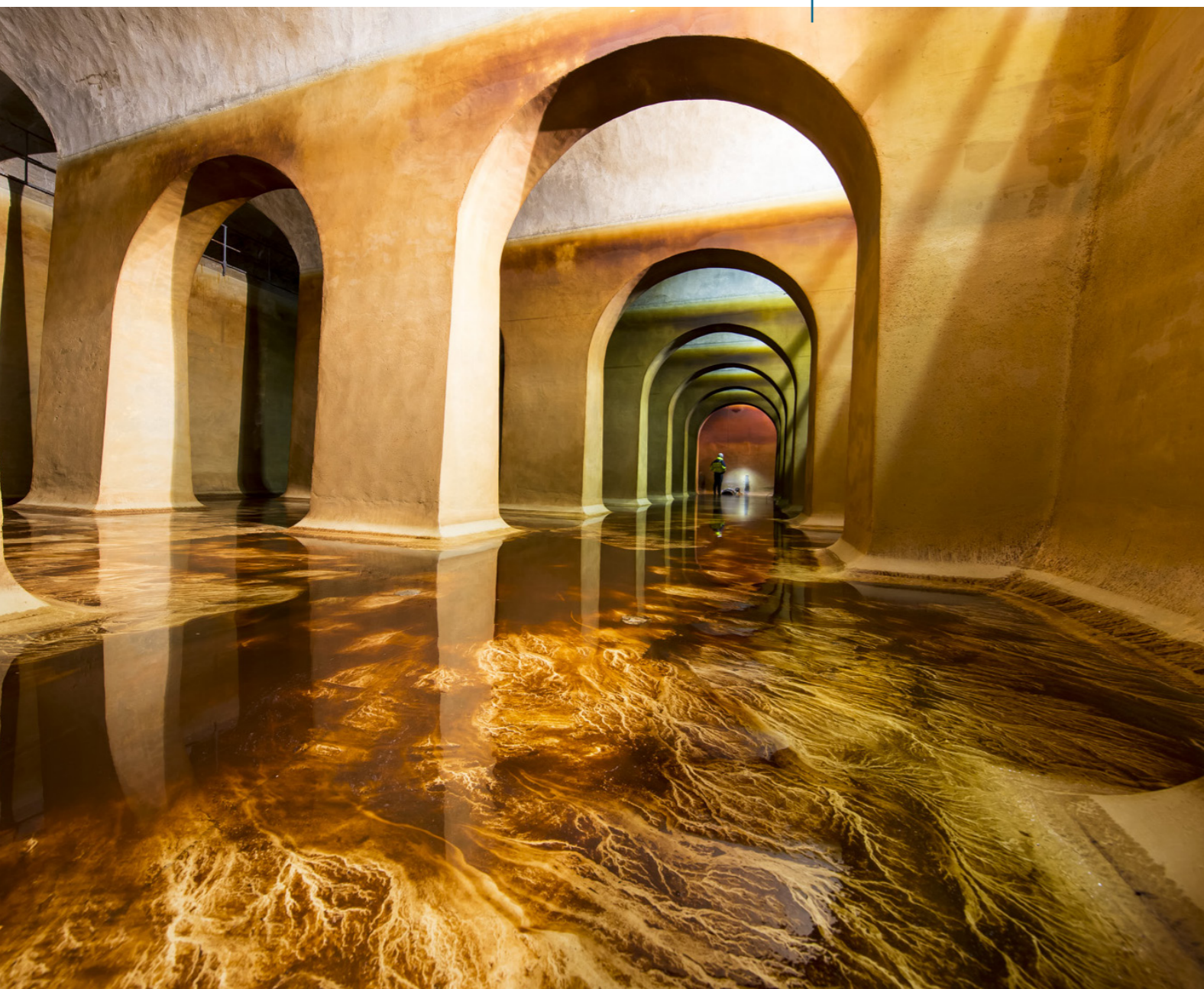
Opération de nettoyage du réservoir de Thabor
