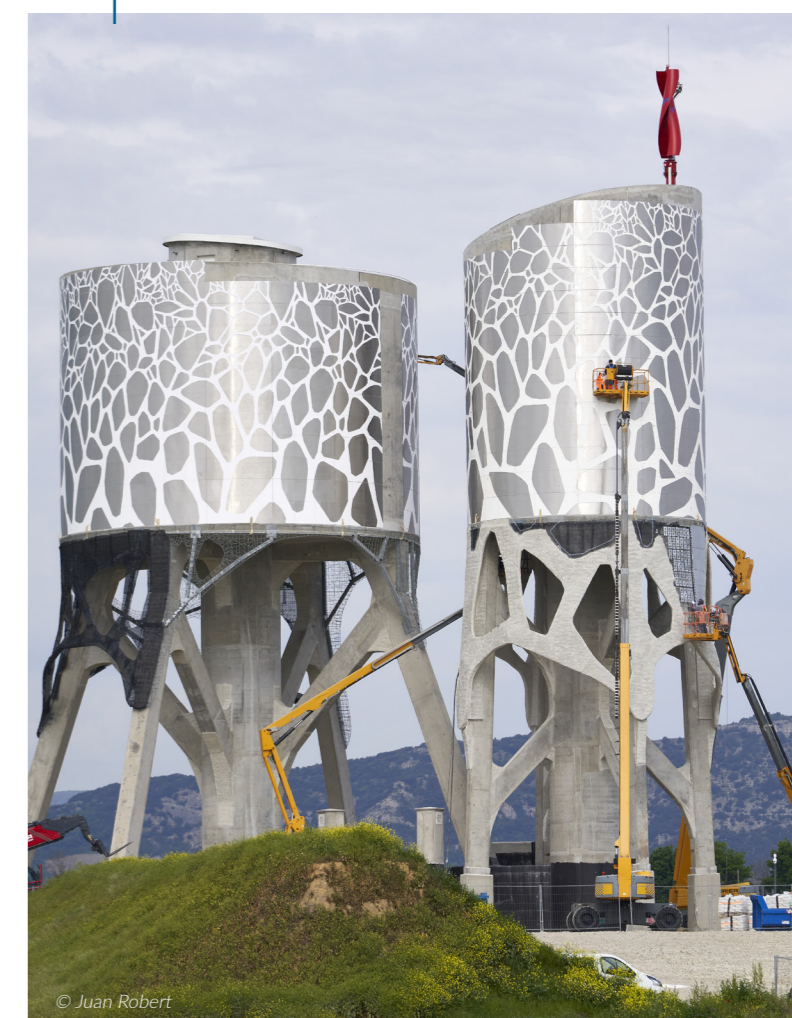
Installation de l'habillage extérieur du château d'eau de Lautagne
