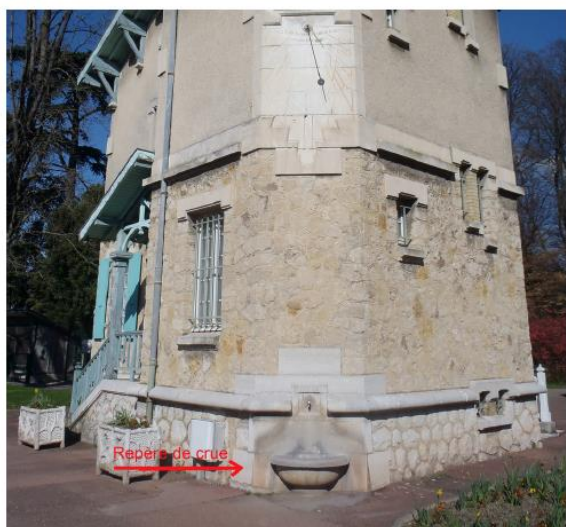
Position du repère de crue sur la maison du gardien du Parc Jovet (photo DDT26)
