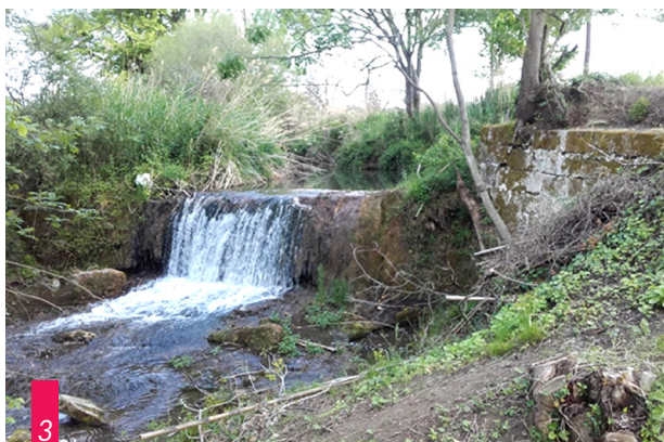
3 - EXEMPLE DE SEUIL À SUPPRIMER DISCONTINUITÉ DE 2M DE HAUTEUR.
